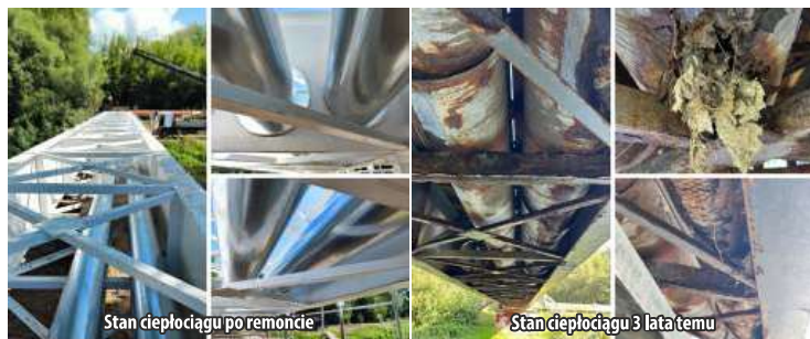
Stan ciepłociągu po remoncie
